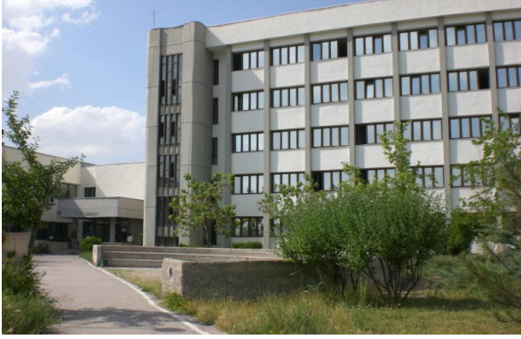
A Blok Zemin Kat-Dekanlık
